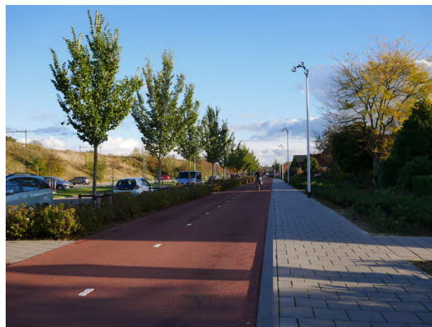
Esempio di via ciclabile pavimentata con asfalto colorato rosso, separata dalla circolazione automobilistica e dai pedoni. (F112 in Olanda, provincia di Gelderland)
